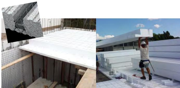
**02 LES MURS HOMIA (4-6-4)®** 14 cm d'épaisseur et une paroi isolante de 6cm en EPS. Absence de pont thermique et parfaite étanchéité à l'air. Parfaite isolation phonique et surtout, une résistance cyclonique et sismique inégalée. Résiste à un séisme équivalent à 12 sur l'échelle de Richter.
